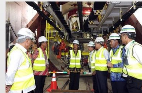
LRT Groundbreaking 9/9/2015 setelah mangkrak sejak Okt 2013
